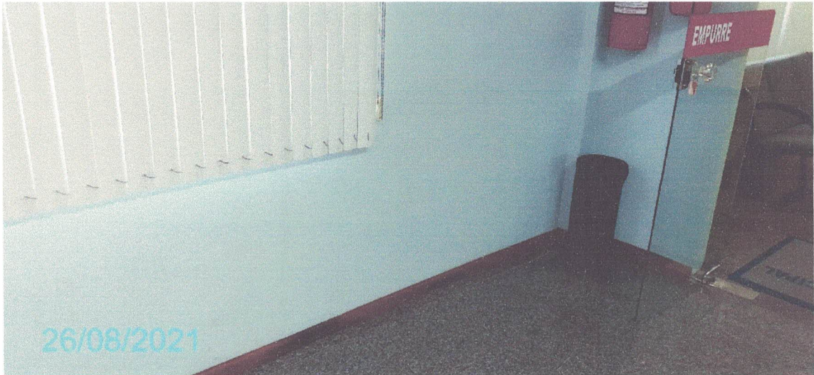
Figura 260 – Paredes do Pavimento Térreo
