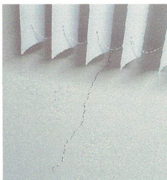
Figura 143– Fotografia do Subsolo
