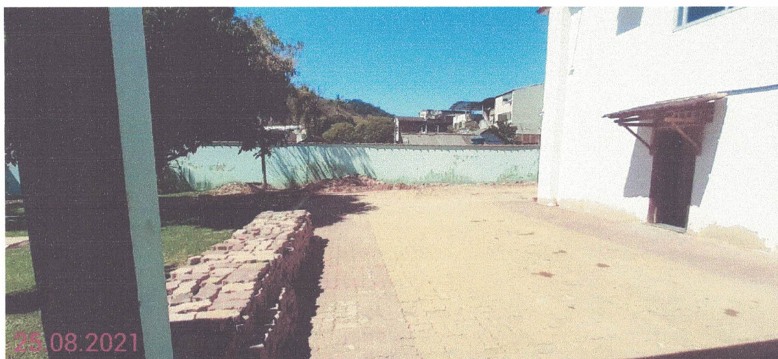
Figura 9 – Área de dispersão pavimentada, área 4 do croquis.
