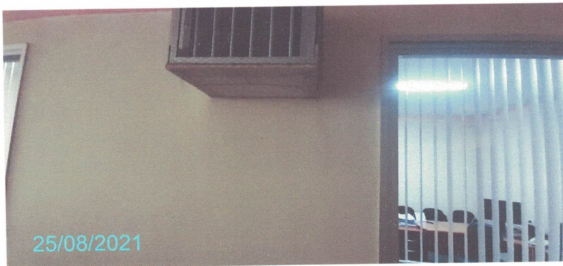
Figura 180 – Paredes do Subsolo
