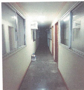
Figura 183 – Paredes do Subsolo
