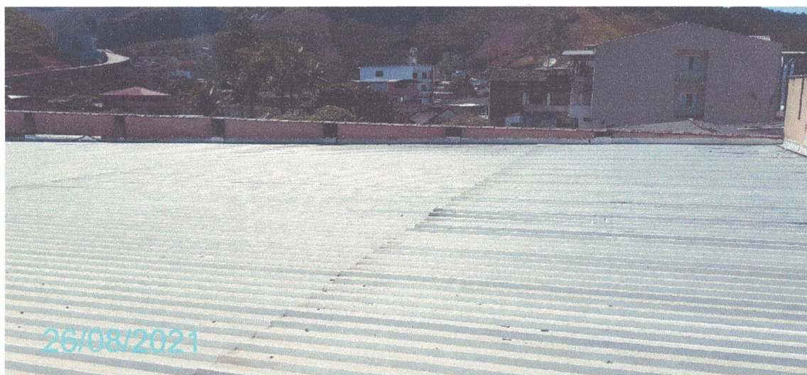
Figura 300 – Fotografia do Telhado.
