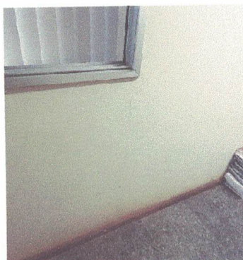
Figura 184 – Paredes do Subsolo
