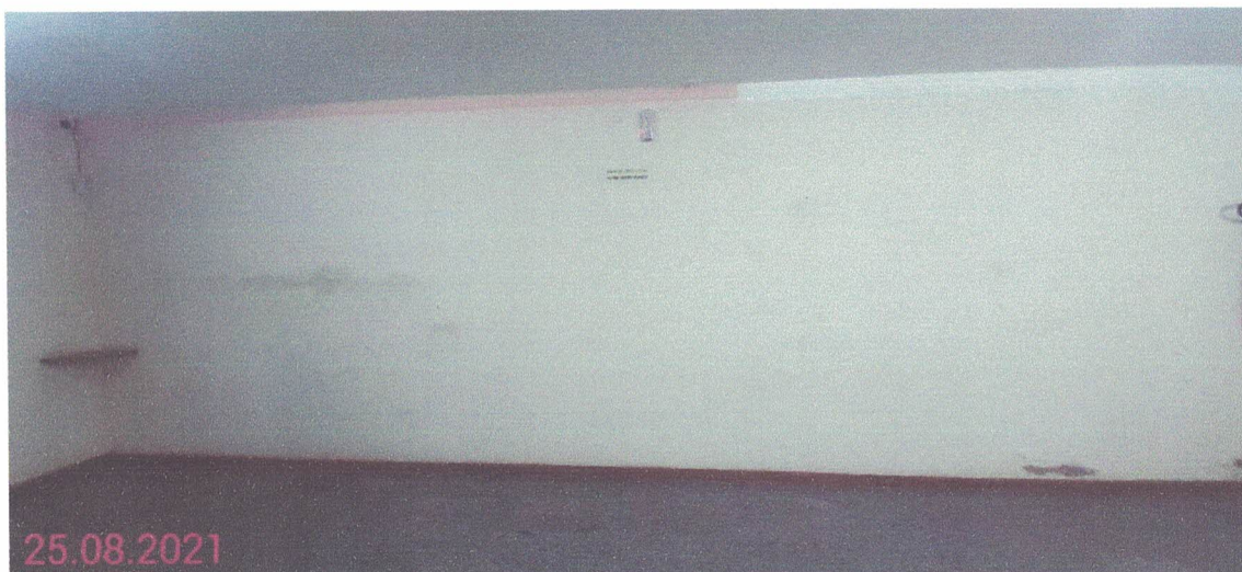
Figura 23 – Parede estrutural do subsolo, vendo-se a esquerda a parede da cozinha.
