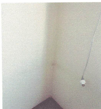
Figura 118– Fotografia do Subsolo
