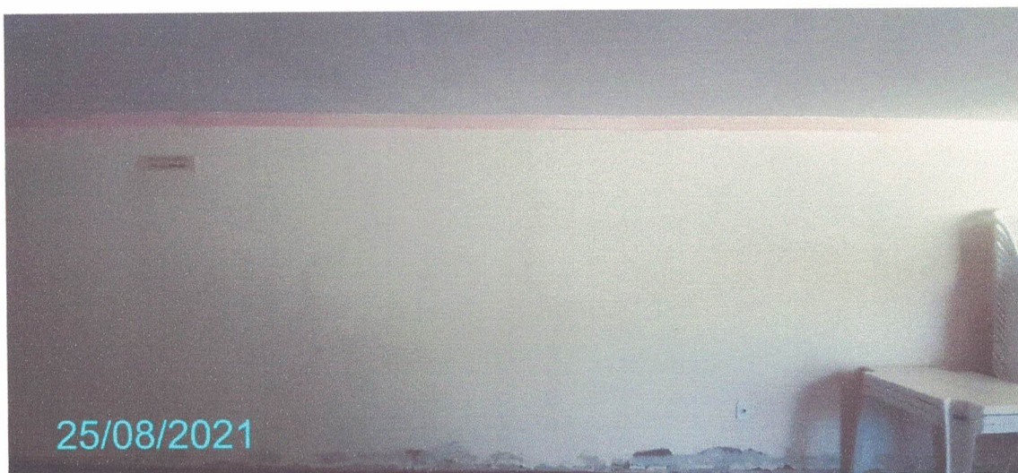
Figura 182 – Paredes do Subsolo
