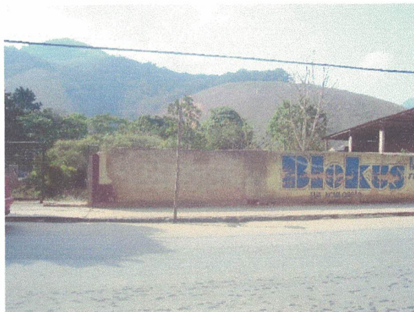
Figura 53 – Fotografia do terreno a época das fundações.
