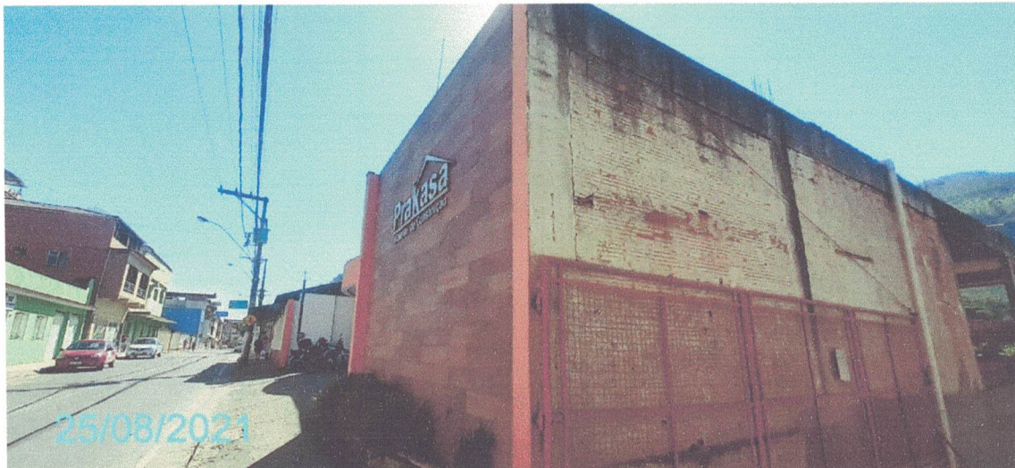
Figura 334 – Fotografia da Área Externa.
