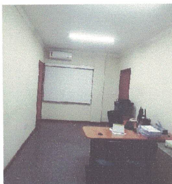
Figura 205 – Paredes do Pavimento Térreo
