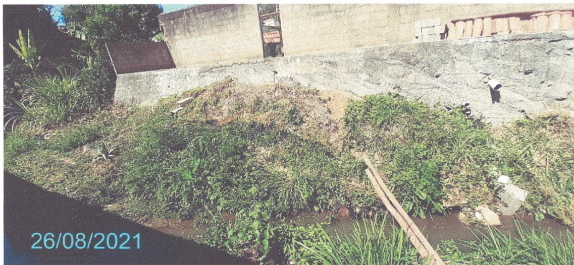
Figura 352– Fotografia da Área Externa.
