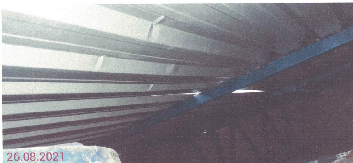
Figura 27 – Visão de aberturas entre telhas e telhas amassadas.
