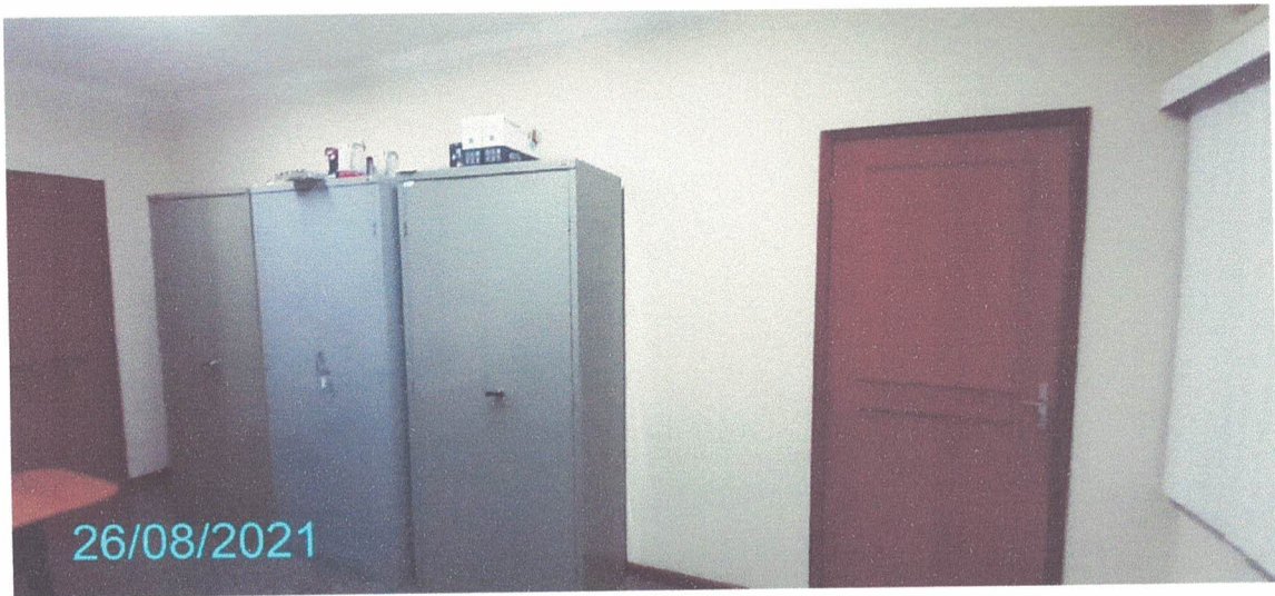
Figura 218– Paredes do Pavimento Térreo
