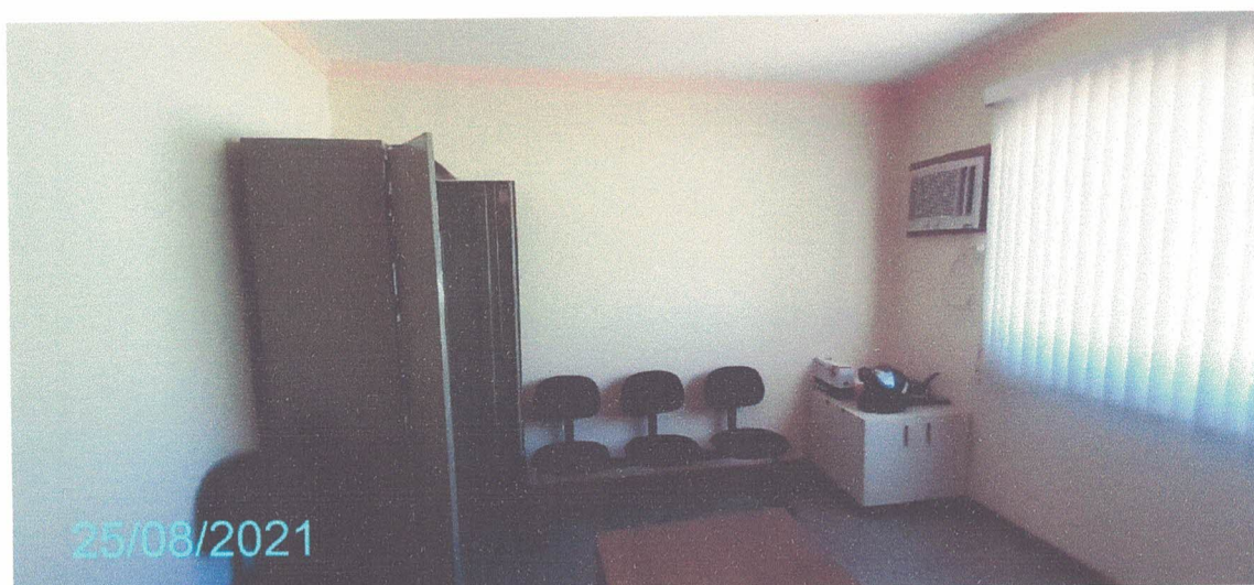
Figura 189 – Paredes do Subsolo
