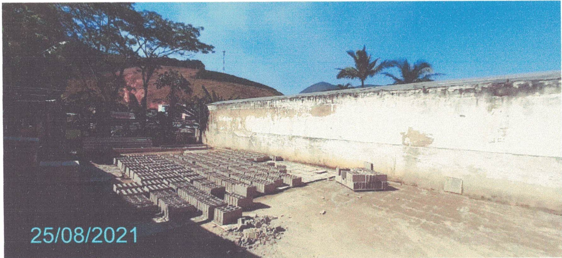
Figura 337 – Fotografia da Área Externa.
