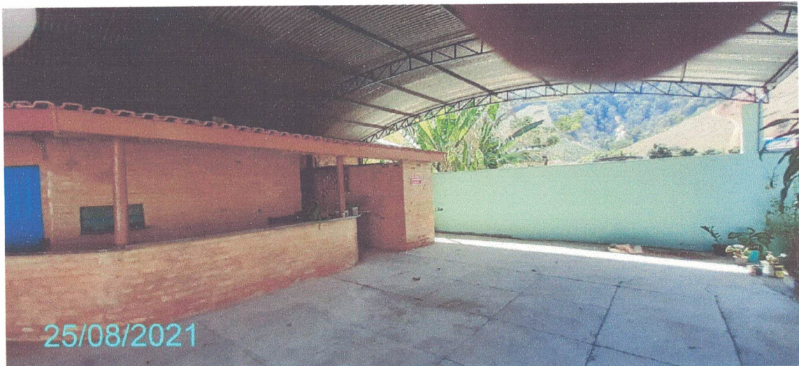
Figura 320 – Fotografia da Área Externa.
