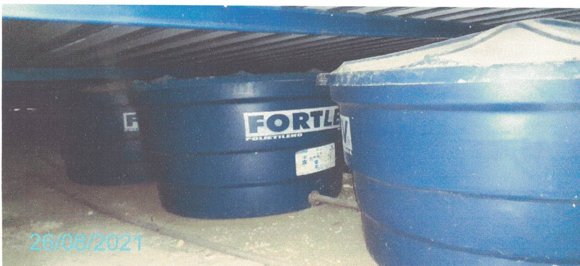
Figura 312 – Fotografia do Telhado.
