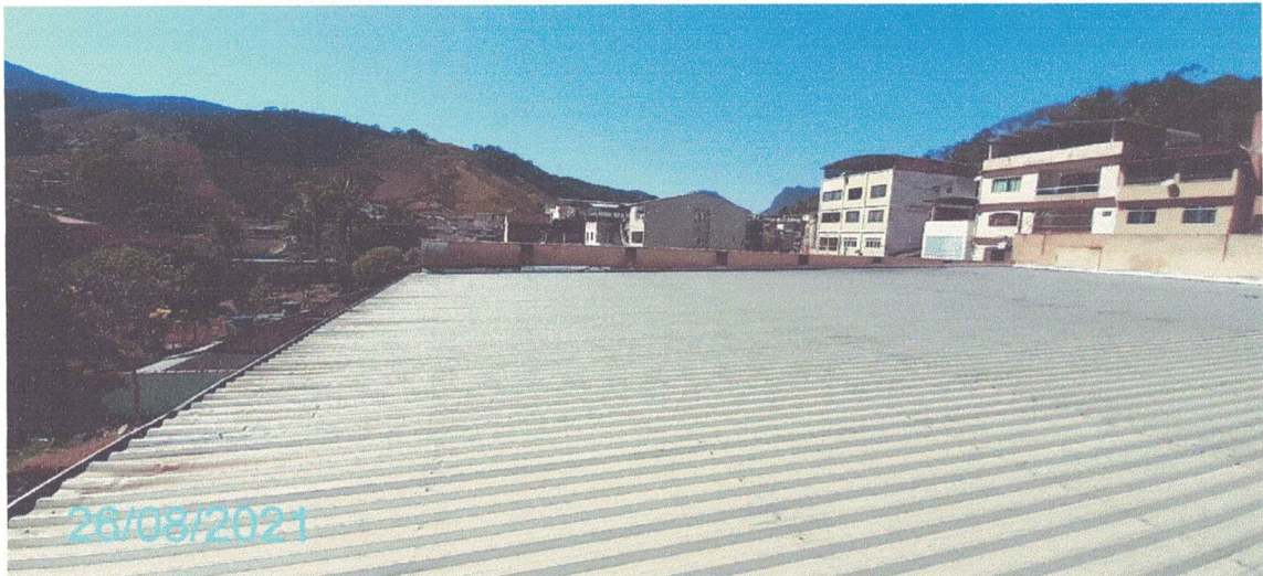
Figura 305 – Fotografia do Telhado.
