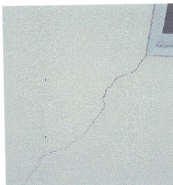
Figura 169 – Paredes do Subsolo
