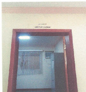
Figura 141– Fotografia do Subsolo
