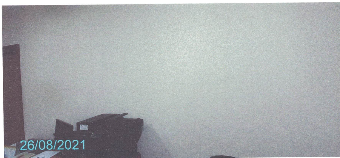
Figura 201 – Paredes do Pavimento Térreo
