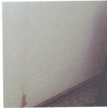
Figura 90 – Fotografia do subsolo.
