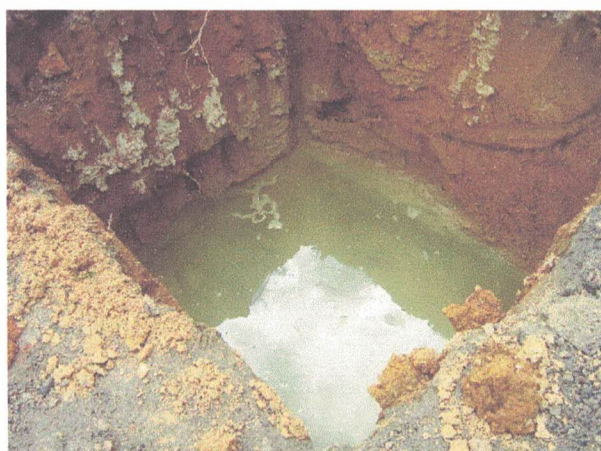
Figura 60 – Fotografia do terreno a época das fundações.
