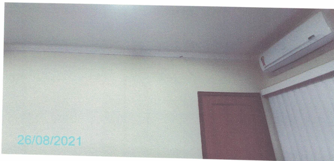
Figura 210 – Paredes do Pavimento Térreo
