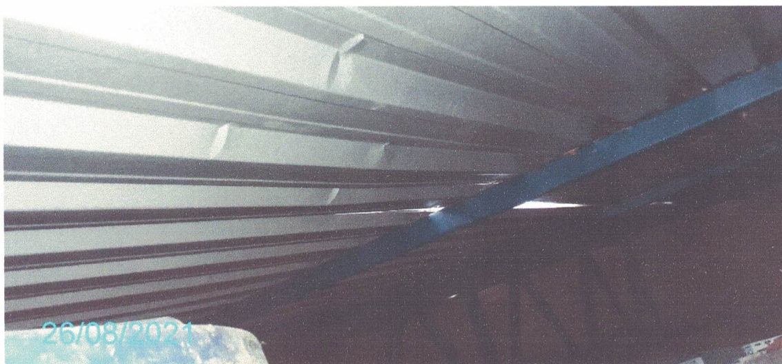
Figura 313 – Fotografia do Telhado
