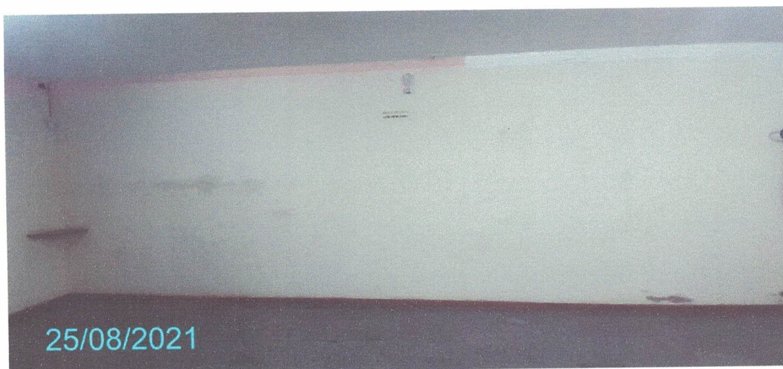
Figura 166– Paredes do Subsolo
