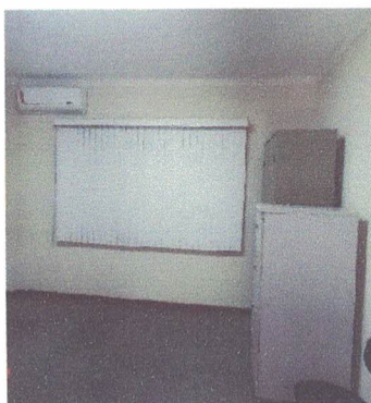
Figura 233– Paredes do Pavimento Térreo
