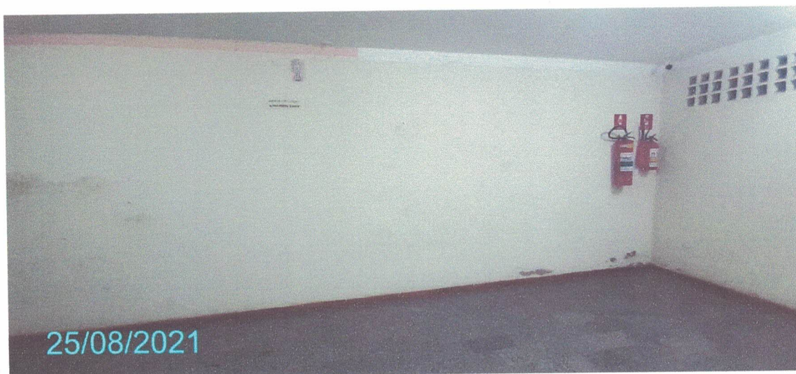
Figura 167 – Paredes do Subsolo
