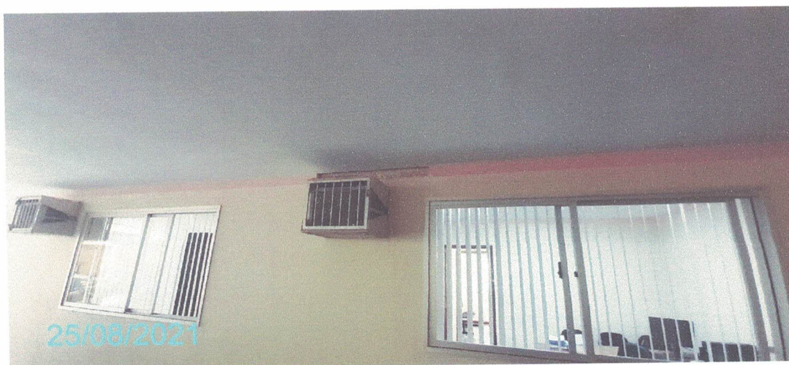
Figura 179 – Paredes do Subsolo
