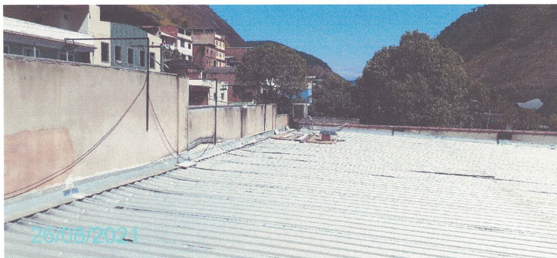
Figura 302 – Fotografia do Telhado.
