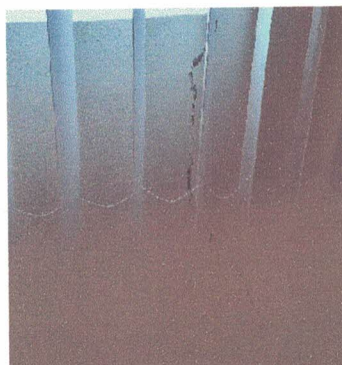
Figura 112– Fotografia do Subsolo
