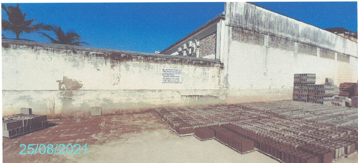
Figura 338 – Fotografia da Área Externa.
