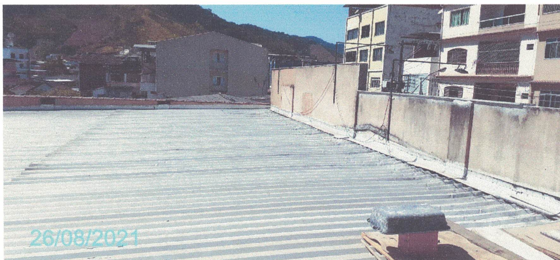
Figura 301 – Fotografia do Telhado.
