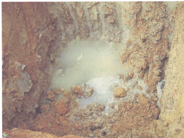
Figura 56 – Fotografia do terreno a época das fundações.
