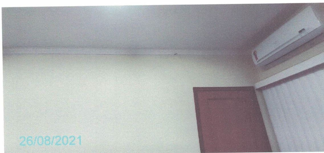
Figura 210 – Paredes do Pavimento Térreo
