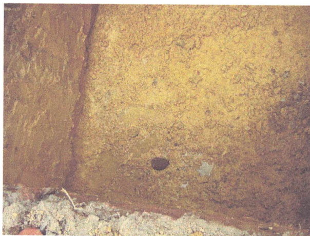
Figura 64 – Fotografia do terreno a época das fundações.
