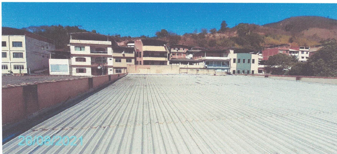
Figura 303 – Fotografia do Telhado.
