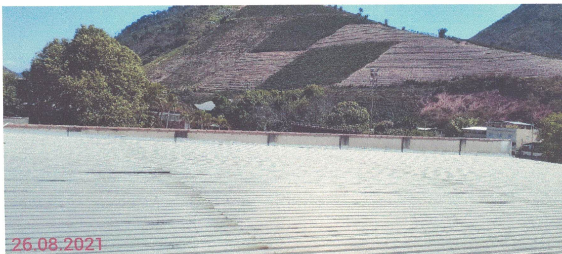
Figura 27 – Visão de aberturas entre telhas e telhas amassadas.
