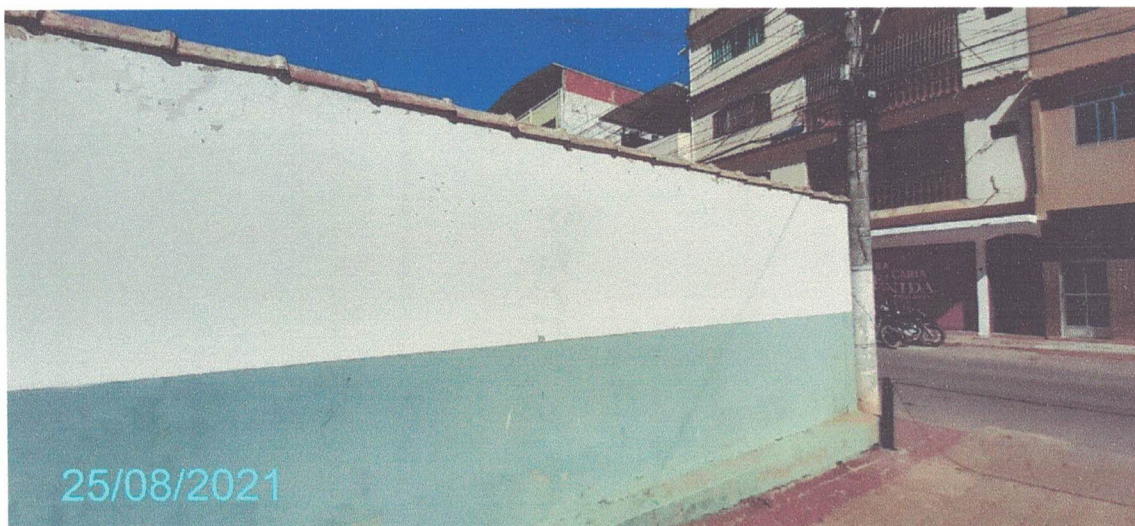
Figura 343 – Fotografia da Área Externa.
