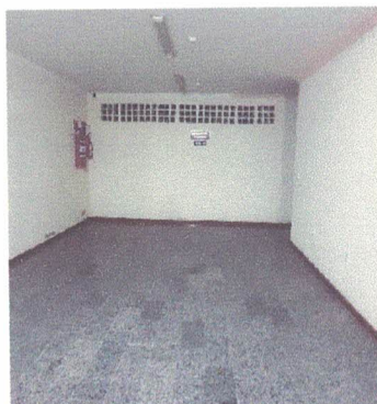
Figura 164– Fotografia do Subsolo
