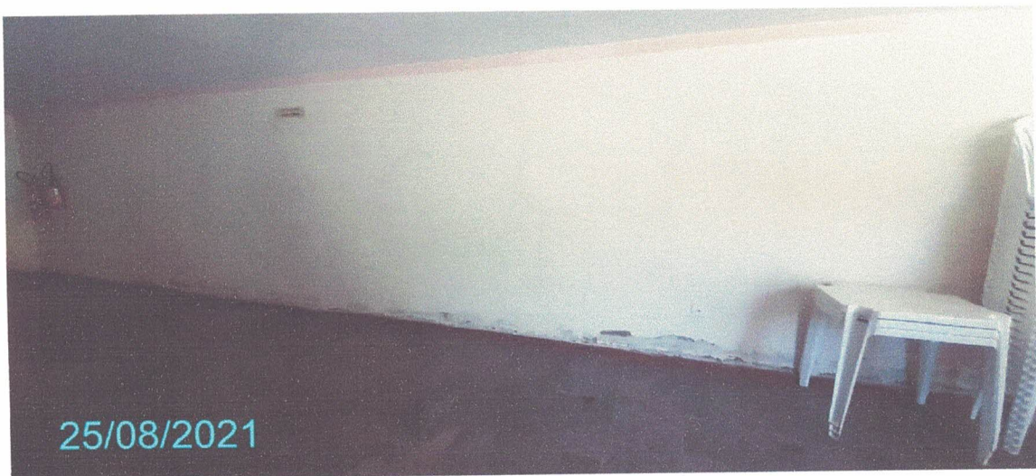
Figura 176 – Paredes do Subsolo
