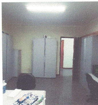
Figura 222– Paredes do Pavimento Térreo
