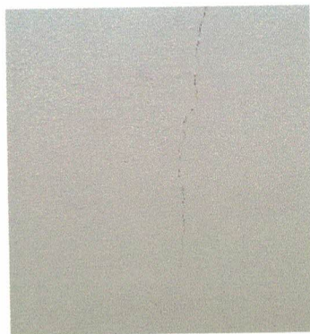
Figura 105– Fotografia do Subsolo
