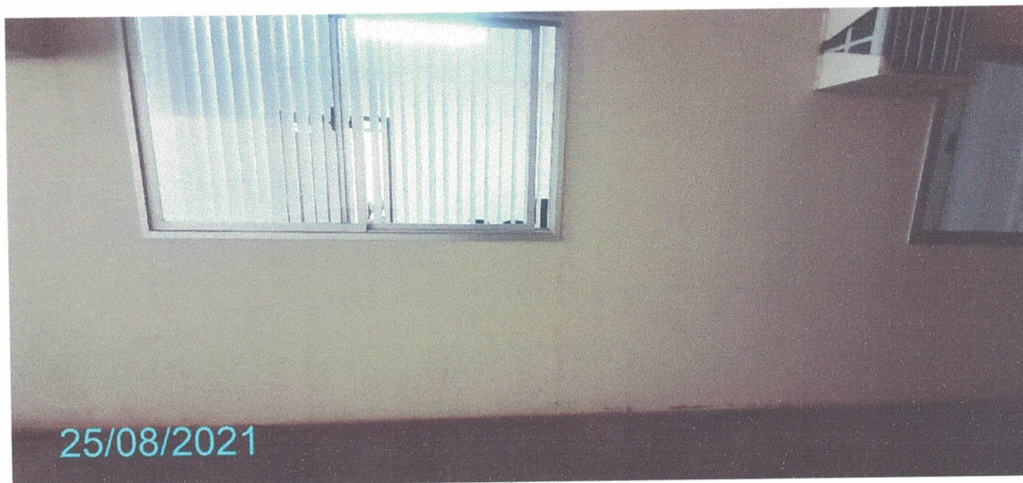
Figura 177 – Paredes do Subsolo
