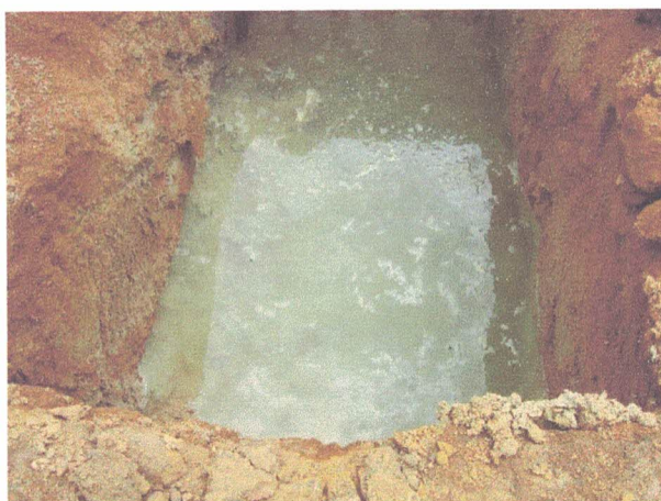
Figura 59 – Fotografia do terreno a época das fundações.
