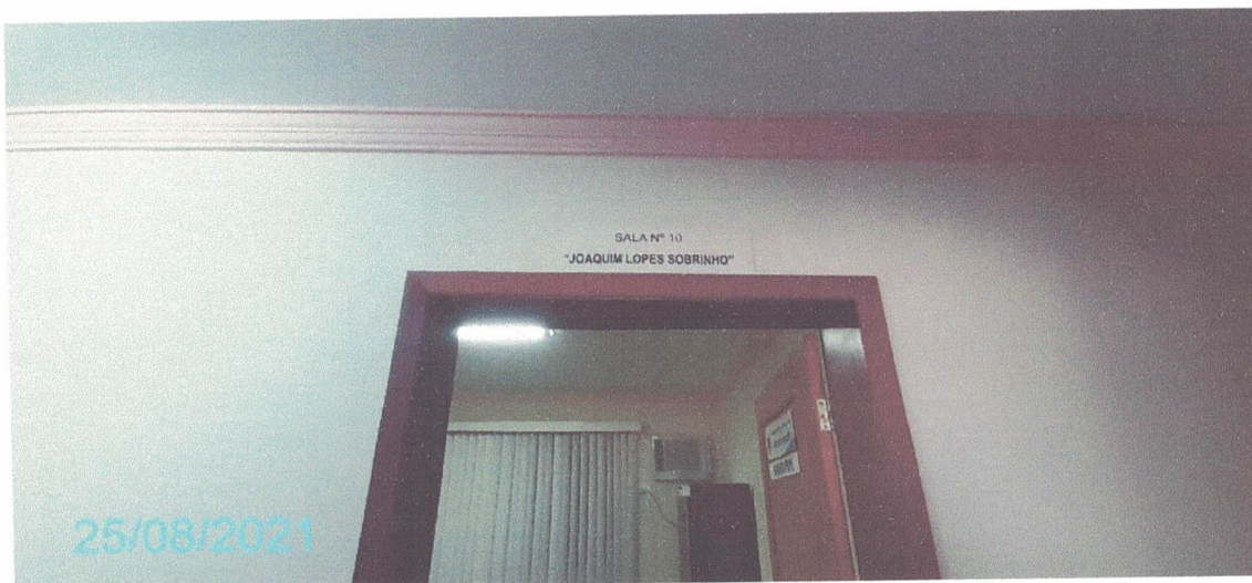
Figura 128– Fotografia do Subsolo
