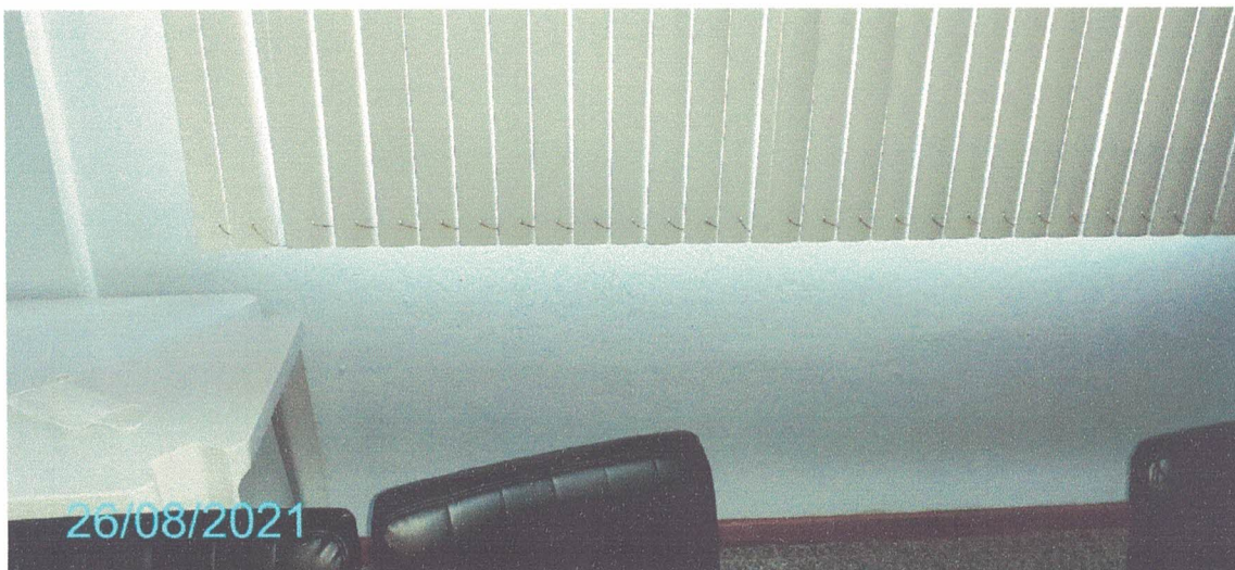
Figura 264 – Paredes do Pavimento Térreo
