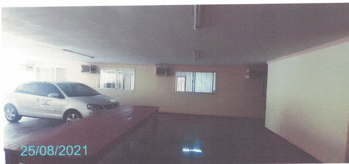
Figura 178 – Paredes do Subsolo
