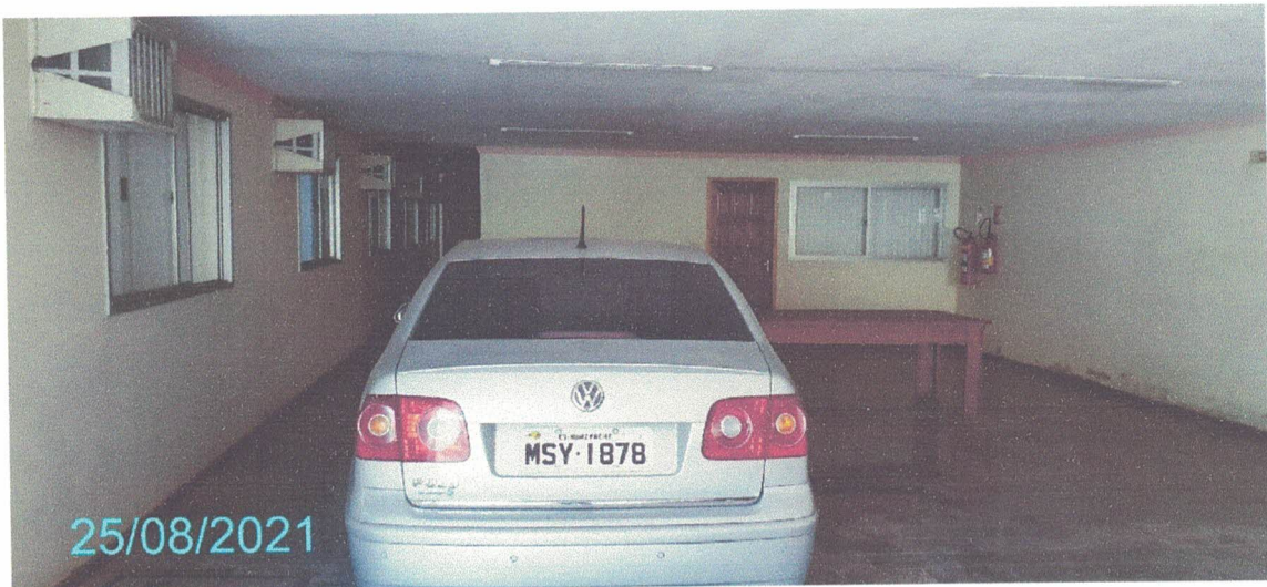
Figura 175 – Paredes do Subsolo
