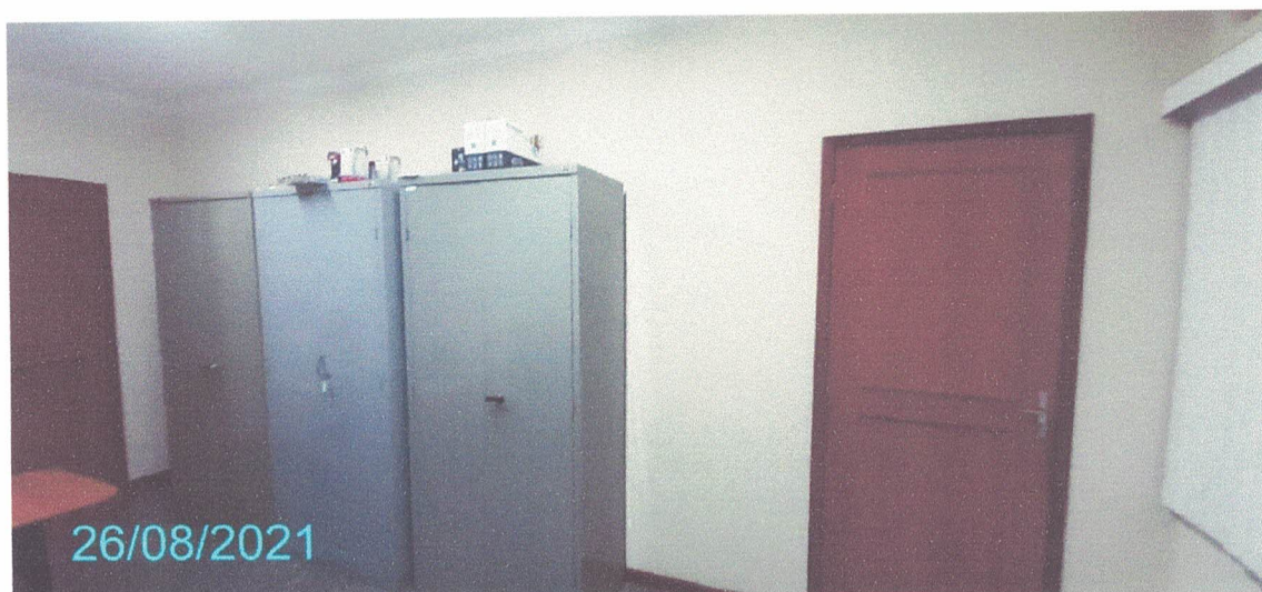
Figura 218– Paredes do Pavimento Térreo
