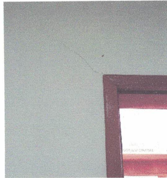
Figura 159– Fotografia do Subsolo
