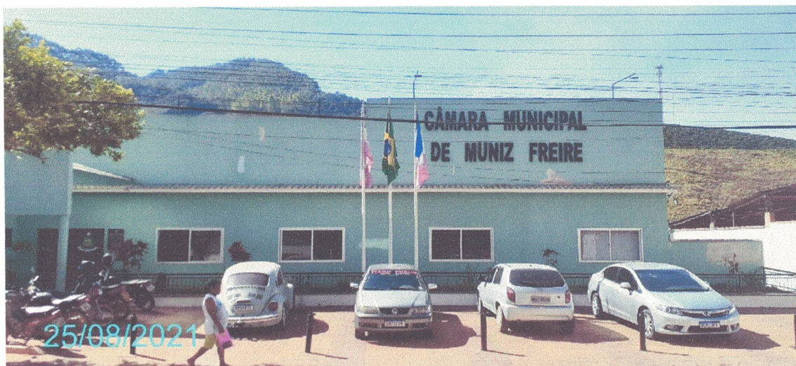
Figura 326 – Fotografia da Área Externa.
