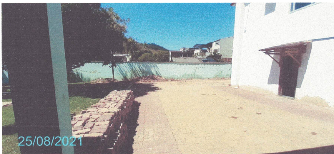
Figura 318 – Fotografia da Área Externa.
