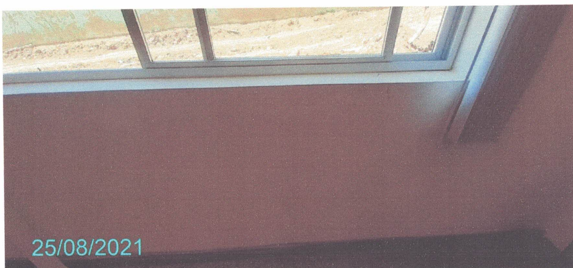
Figura 97 – Fotografia do Subsolo
