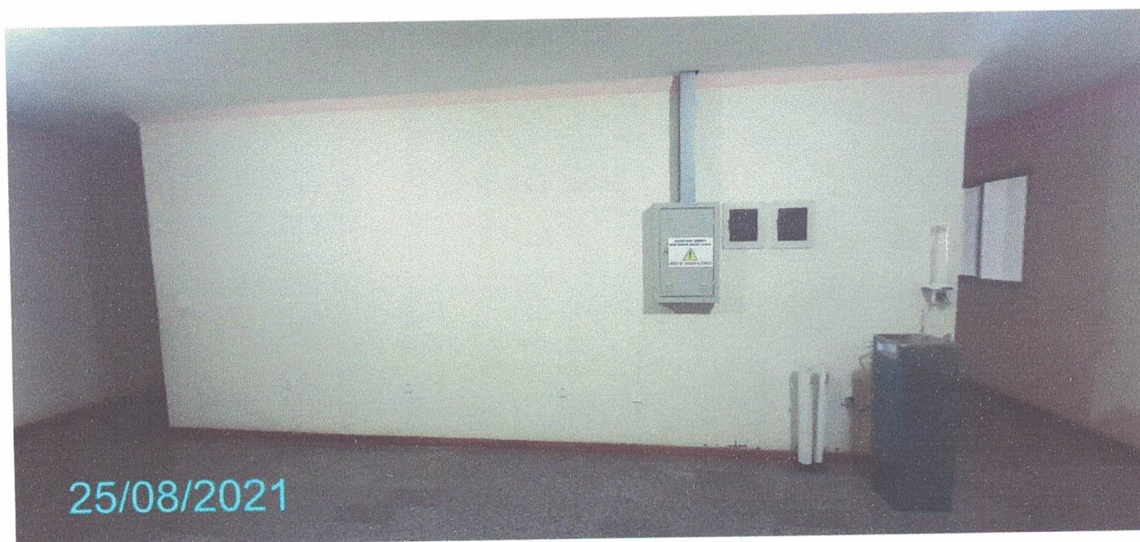
Figura 172 – Paredes do Subsolo
