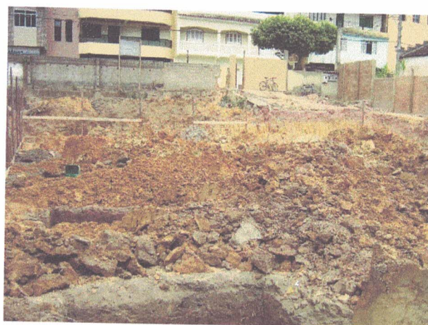
Figura 66 – Fotografia do terreno a época das fundações.
