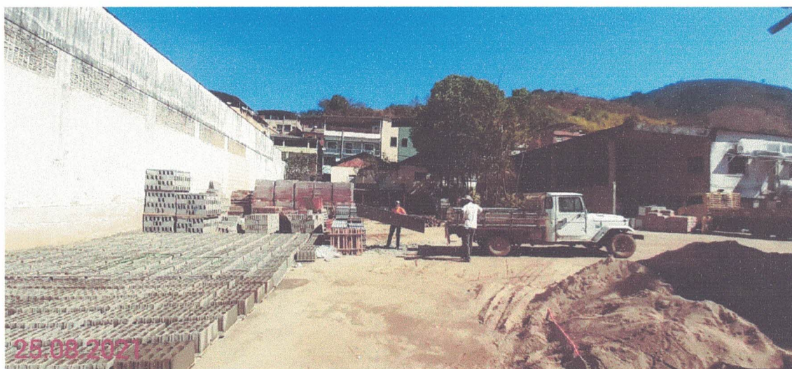
Figura 12 – Vizinho a direita da Câmara Municipal – Prakasa, Material de Construção.
