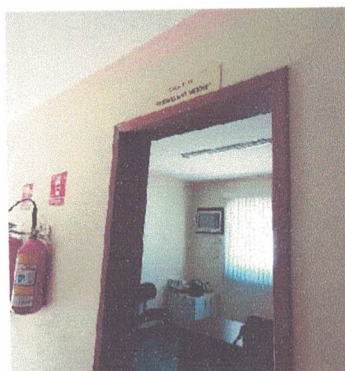
Figura 187 – Paredes do Subsolo
