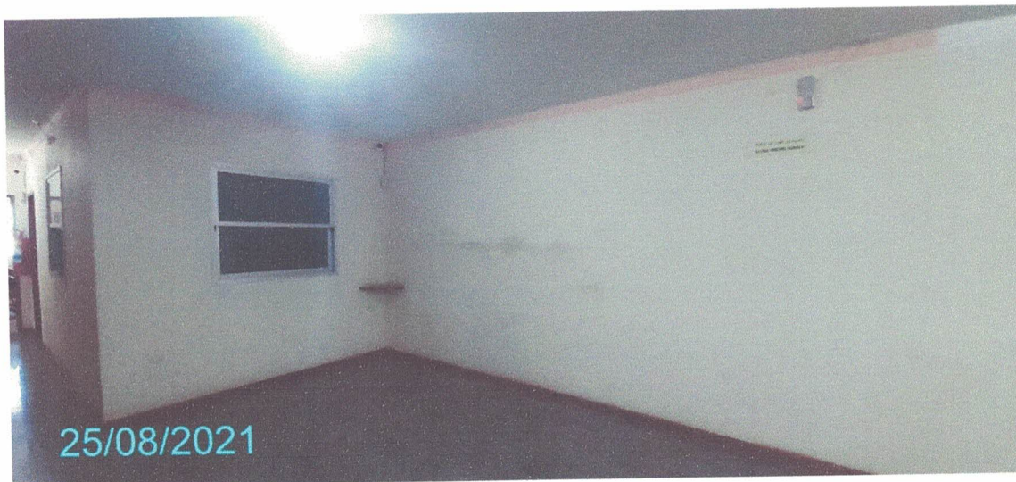
Figura 168 – Paredes do Subsolo
