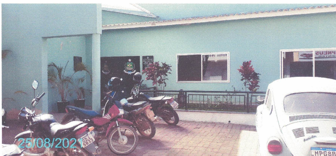
Figura 324 – Fotografia da Área Externa.
