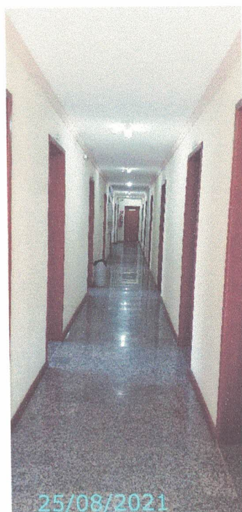
Figura 67 – Fotografia do subsolo
