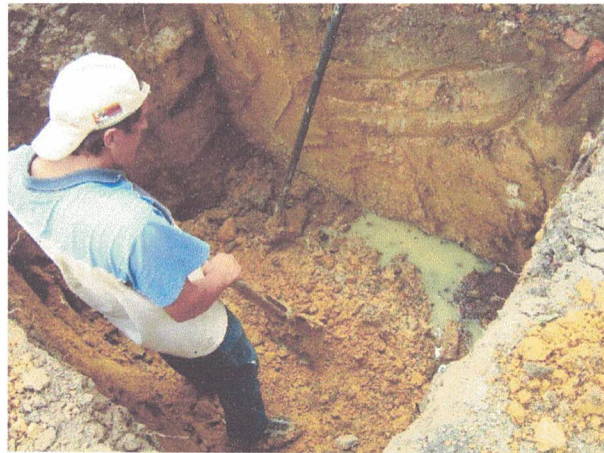
Figura 62 – Fotografia do terreno a época das fundações.
