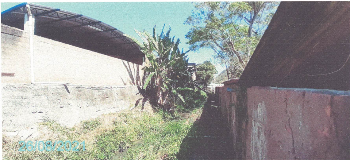
Figura 350 – Fotografia da Área Externa.
