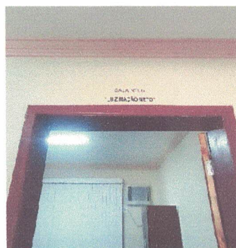
Figura 134– Fotografia do Subsolo
