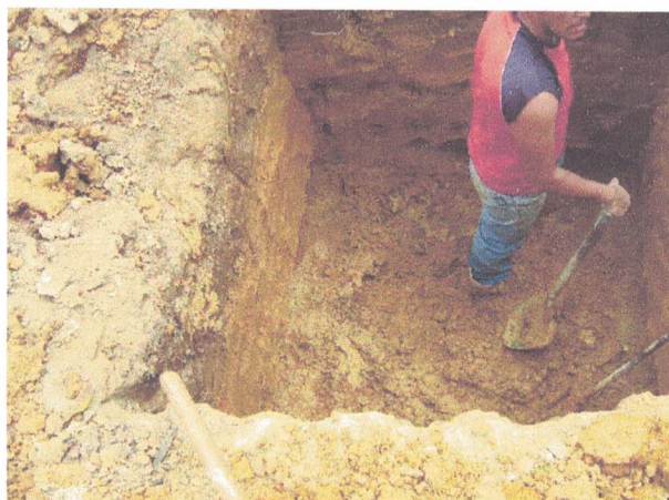
Figura 63 – Fotografia do terreno a época das fundações.
