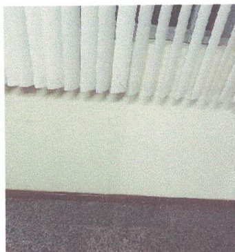
Figura 130– Fotografia do Subsolo
