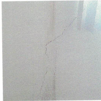
Figura 80 – Fotografia do subsolo.
