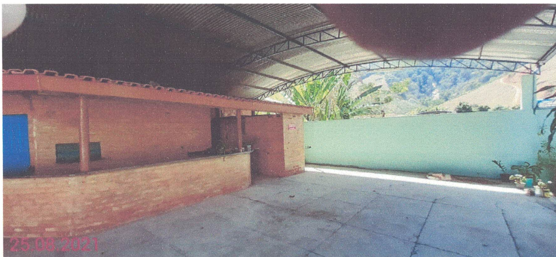
Figura 16 – Vista do anexo sob a cobertura de estrutura metálica.
