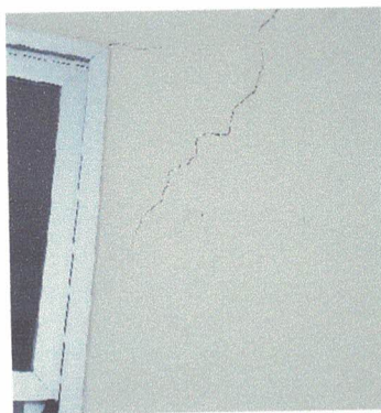
Figura 171 – Paredes do Subsolo
