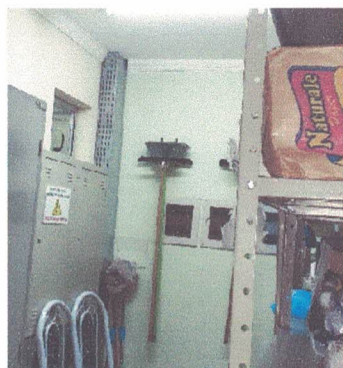
Figura 197 – Paredes do Pavimento Térreo
