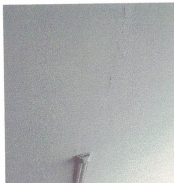
Figura 181 – Paredes do Subsolo
