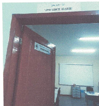
Figura 220– Paredes do Pavimento Térreo
