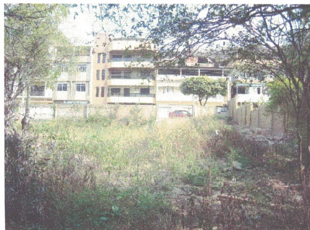
Figura 51 – Fotografia do terreno a época das fundações.
