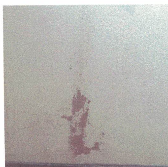
Figura 89 – Fotografia do subsolo.
