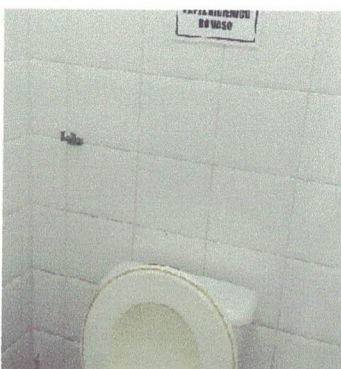
Figura 281 – Paredes do Pavimento Térreo
