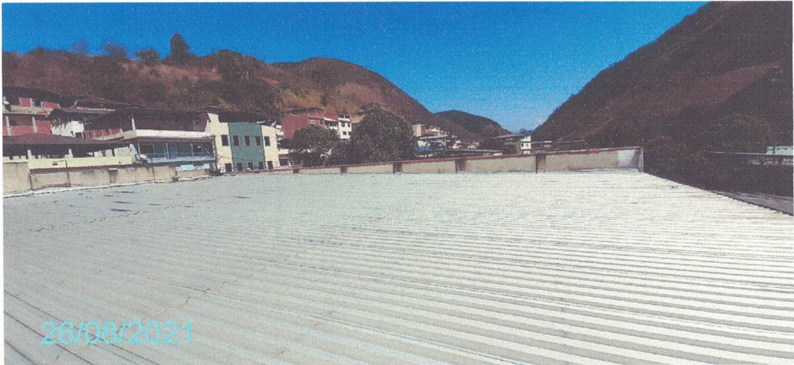
Figura 304 – Fotografia do Telhado.
