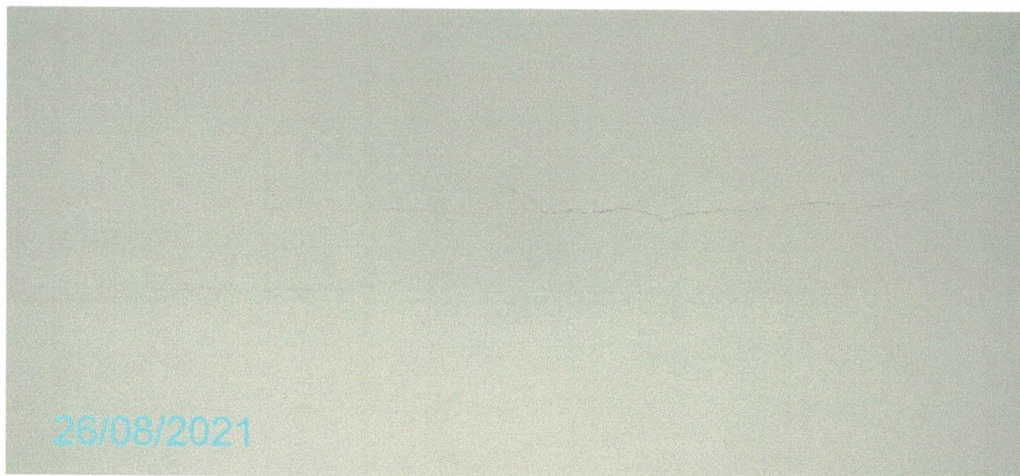
Figura 290– Paredes do Pavimento Térreo
