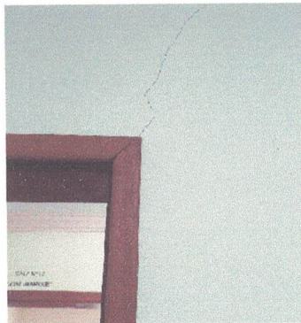
Figura 124– Fotografia do Subsolo
