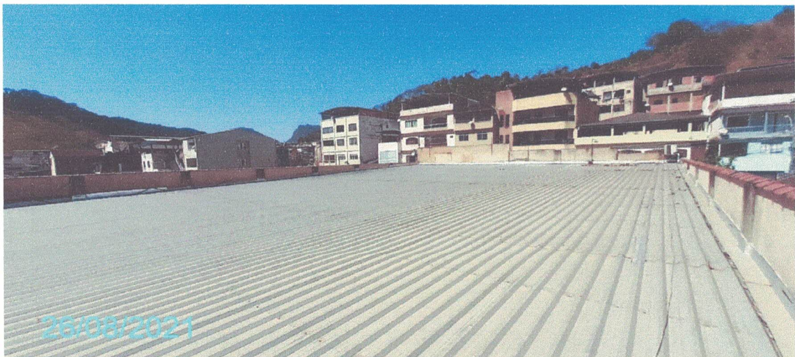
Figura 306 – Fotografia do Telhado.
