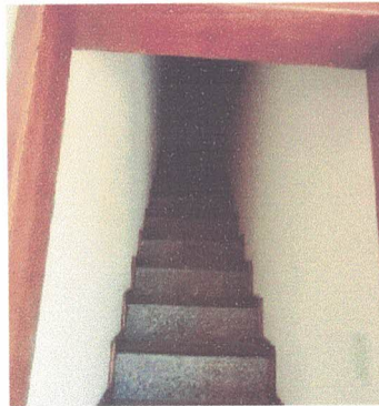
Figura 162– Fotografia do Subsolo
