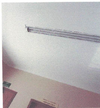
Figura 230– Paredes do Pavimento Térreo
