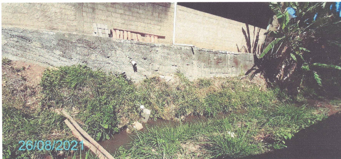
Figura 351 – Fotografia da Área Externa.
