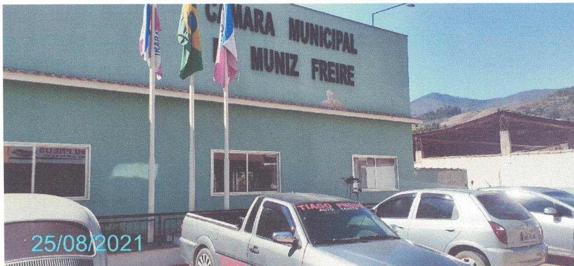
Figura 325 – Fotografia da Área Externa.
