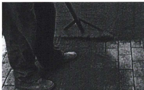
Figura 7 – Selagem das juntas
