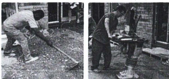
Figura 3 – Espalhamento do material da base e compactação da base.
