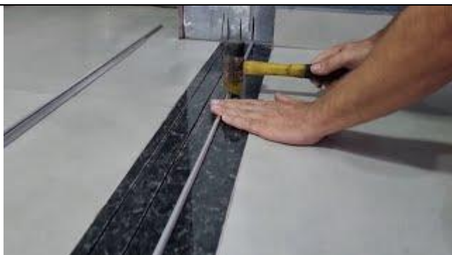
Modelo do sistema da porta (trilho e guia escondidos, instalação da fechadura)
