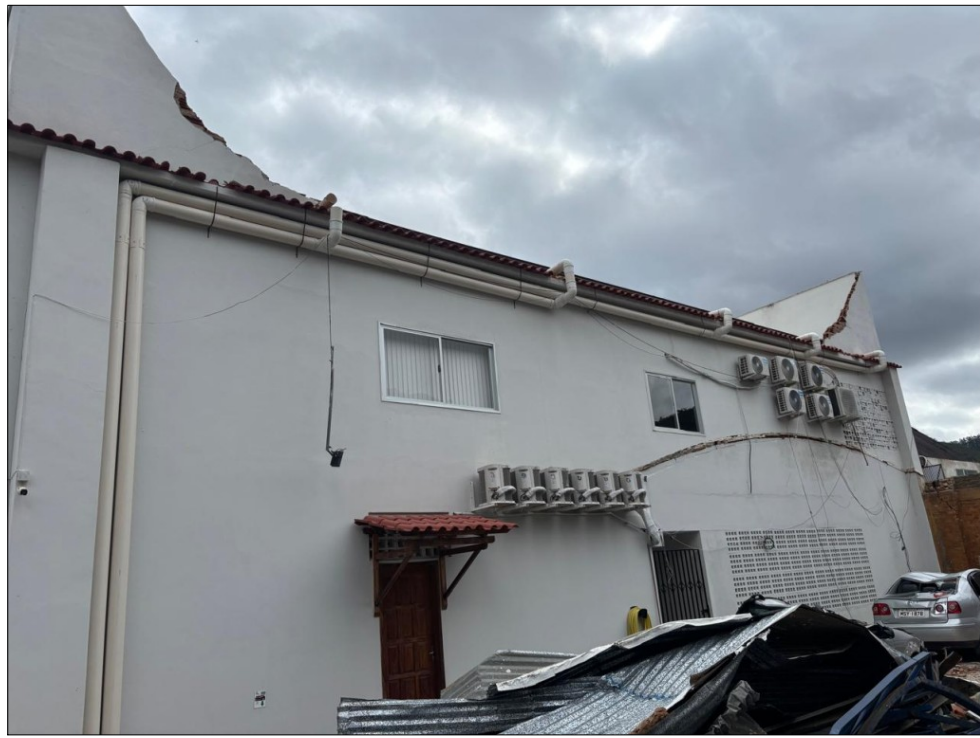
03 IMAGEM - PLATIBANDA COLAPSADA Sem Escala
