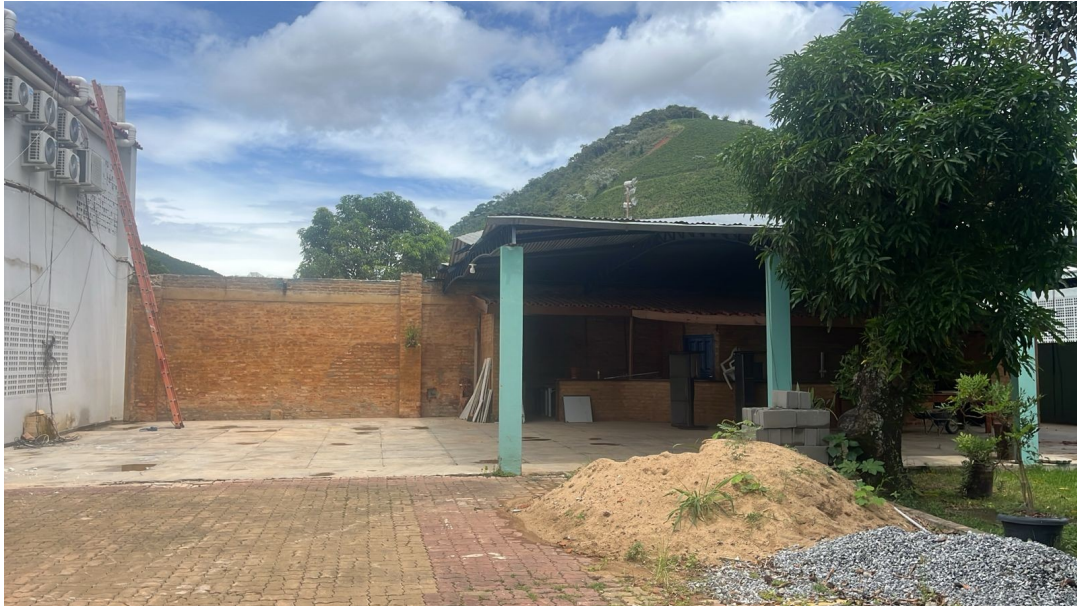
Fotografia 01: Galpão a ser demolido
