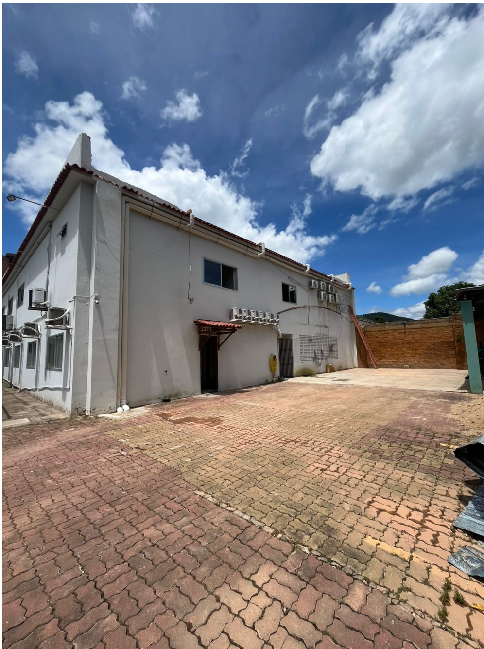
Fotografia 1 - Local de Execução da Nova Platibanda.
