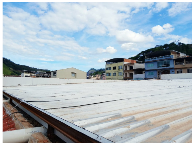
Fotografia 3 – Calha a ser trocada.
