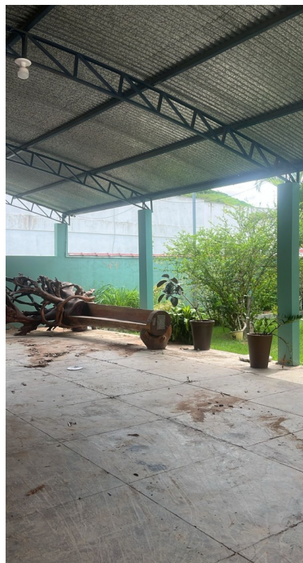
Fotografia 02 – Galpão a ser demolido
